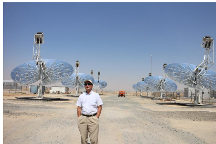
Cleanergy(瑞典)，太阳能碟式斯特林系统（10×12kW）
